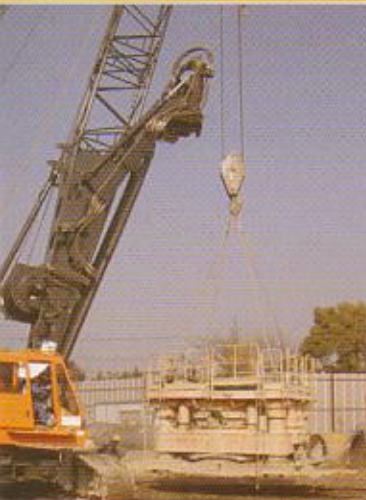
RT200A II 杭芯移動
