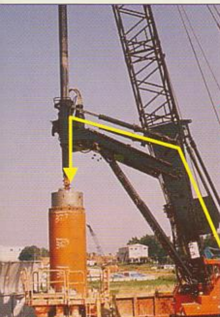
シリンダサポートのフロントフレーム機構
