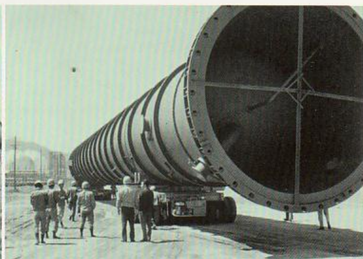
70トントセミトレーラ及び150トントポルトトレーラに依るタワーの運搬
