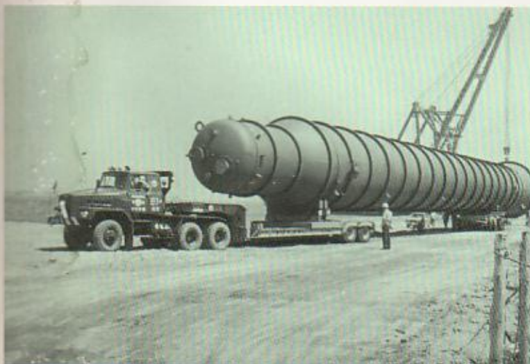
70トントセミトレーラ及び150トントポルトトレーラに依るタワーの運搬
